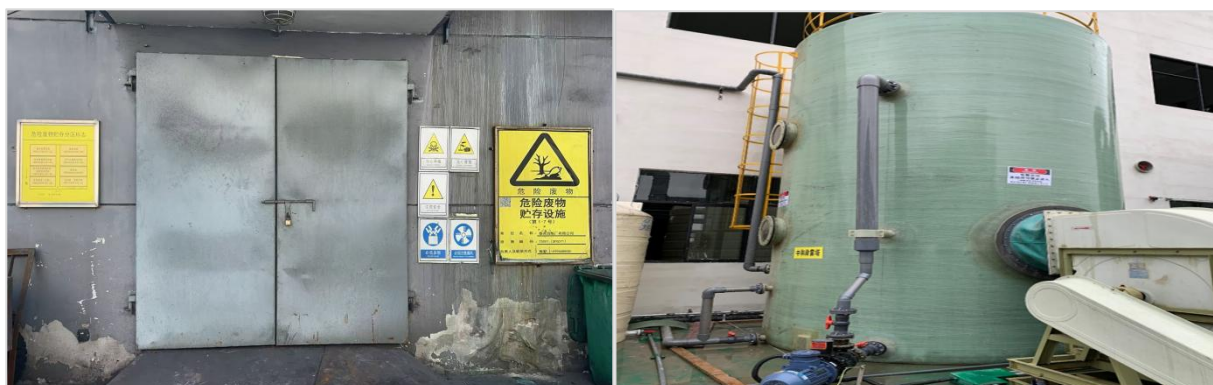
危险废物暂存仓库（左）和废气处理装置（右）
